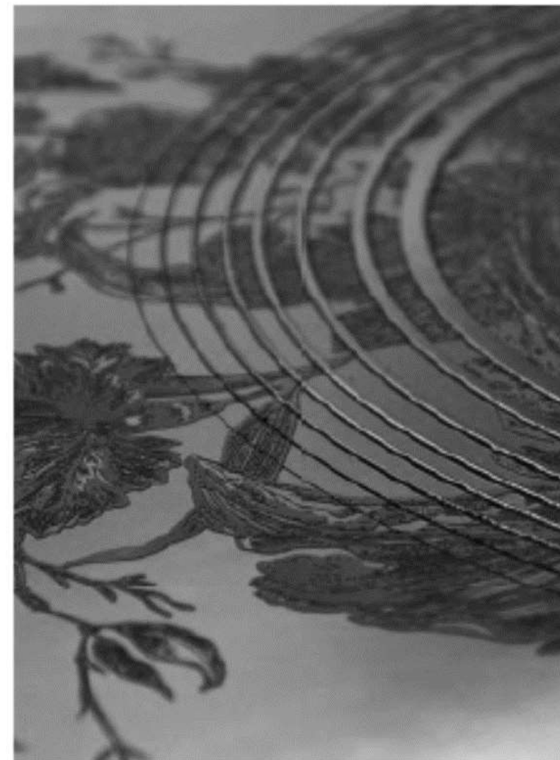
Sérigraphie sur béton par application d'un désactivant Grace Construction Products Pieri et GRAPHICRELIEF
