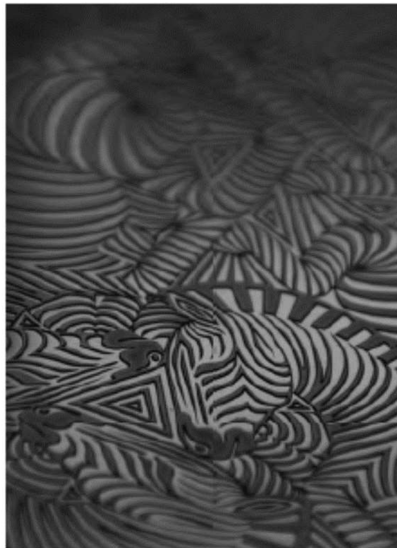
Sérigraphie sur béton par application d'un désactivant Grace Construction Products Pieri et GRAPHICRELIEF
